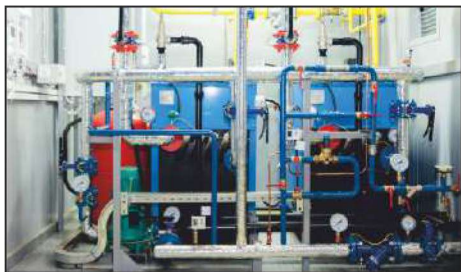
ТГУ-300 изготовлена для объекта в г. Нягани (ХМАО). Габаритные размеры установки - 2800x2200x2700 мм
